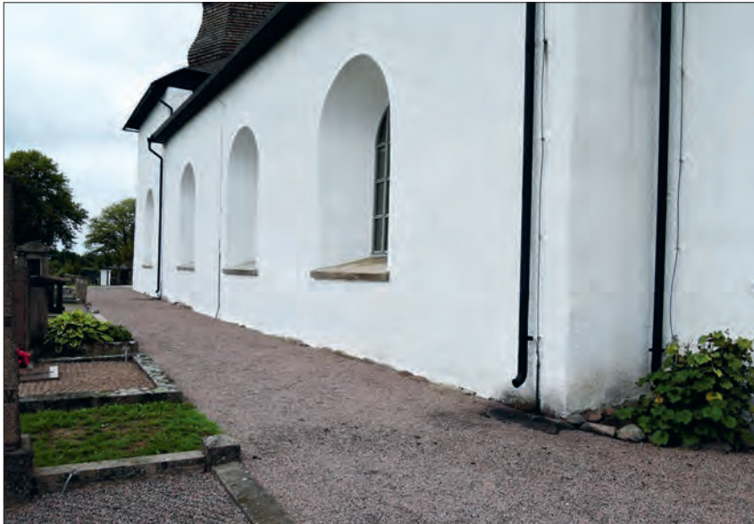
Figur 3. Den nuvarande kyrkans södra fasad med de synliga grundstenarna. Närmast i bild det ursprungliga långhusets slåta stenar och närmast tornet den senare tillbyggnadens mer kantiga grund. Foto: Lena Bjuggner.
